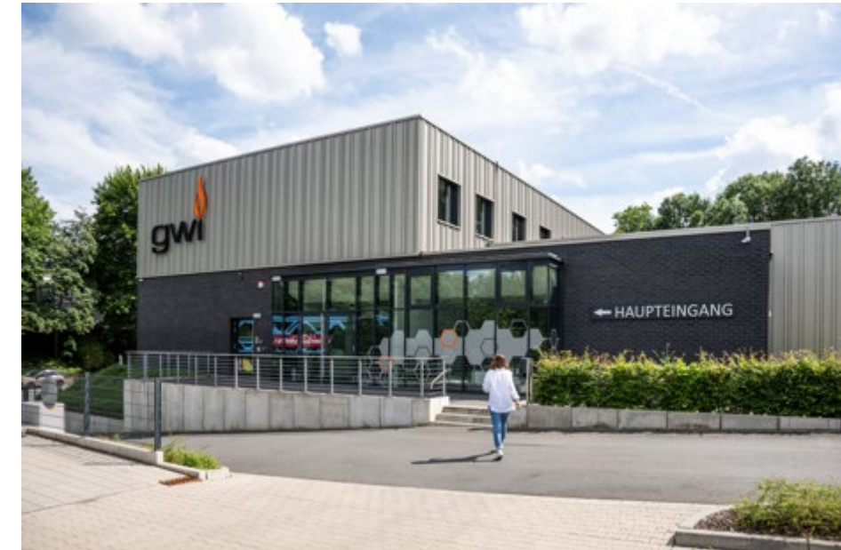
Haupteingang des GWl an der Hafenstraße in Essen
